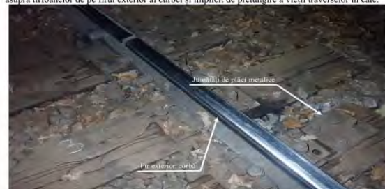
foto nr. 3 – jumătăți de plăci metalice montate înspre exteriorul căii pe capetele traverselor
