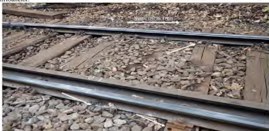
foto nr.4: starea tehnică a căii pe zona producerii accidentului
