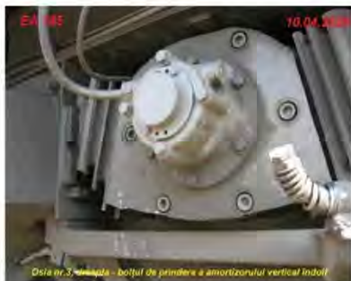
Foto nr.2 - Imagini ale suportului de fixare a amortizorului vertical (urechea) de cutia locomotivei rupt, bolțul de fixare a amortizorului pe legătura de gardă îndoit și urme de lovire recentă a capacului de protecție/gresare al osiei nr.3, dreapta
