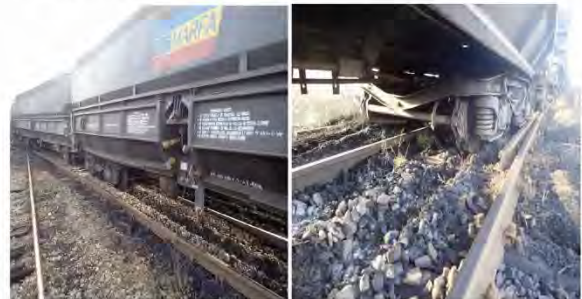
foto nr. 8,9: poziția vagoanelor deraiate, la momentul opririi trenului
