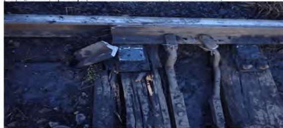
foto nr. 7: starea acului drept al schimbătorului de cale nr. 11, după accident
