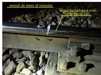
Foto nr.1 - firul exterior al curbei - șina din partea dreaptă a sensului de mers al trenului urma de pășire a suprafeței de rulare a ciupercii șinei
