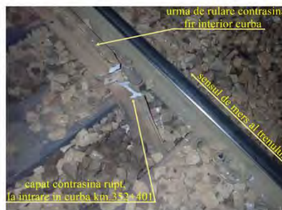
Foto nr.2 - firul interior al curbei km.352+401 - capăt contrașină rupt și urme de rulare pe suprafața contrașinei
