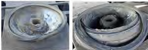
Foto nr.4 crapodina inferioară cu plăcile de poliamidă deteriorate (în stânga: boghiul cu roțile 1+4, în dreapta: boghiul cu roțile 5+8)
