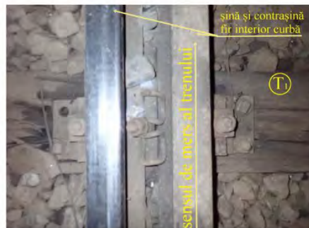
Foto nr.3 - traversa necorespunzătoare T 1
