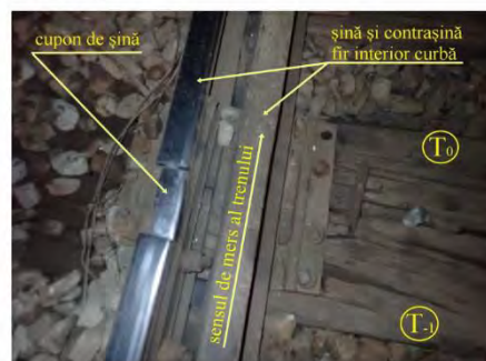
Foto nr.4 - traversele necorespunzătoare T 0 și T -1 și modul de alcătuire al joantei pe firul interior al curbei
