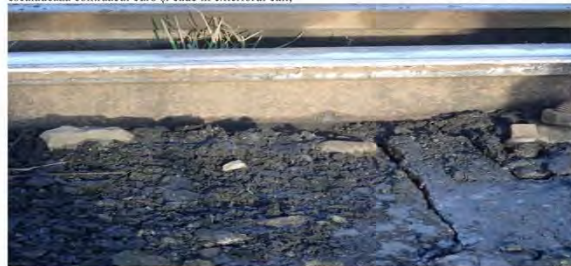
foto nr. 6: urme de frecare a roții din partea stângă pe flancul activ al ciupercii șinei, după punctul 0'
